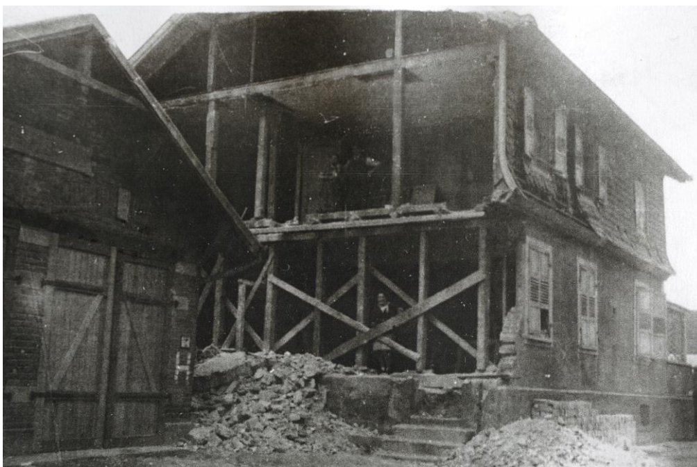
Au premier plan, le dépôt d'incendie à côté de la maison Kolb endommagée (1 rue de l'Église).
