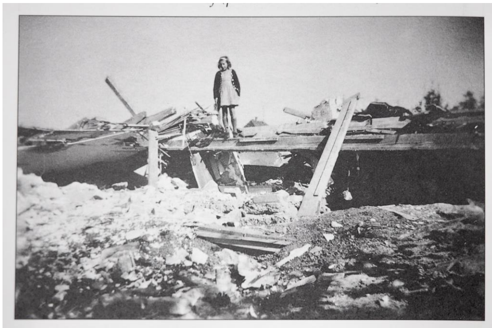
Jeannette Maury née Oertel sur les gravats de la maison détruite lors du bombardement.
