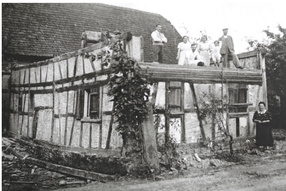
Rue de l'église, maison détruite entre le n°1 et le n°3.
