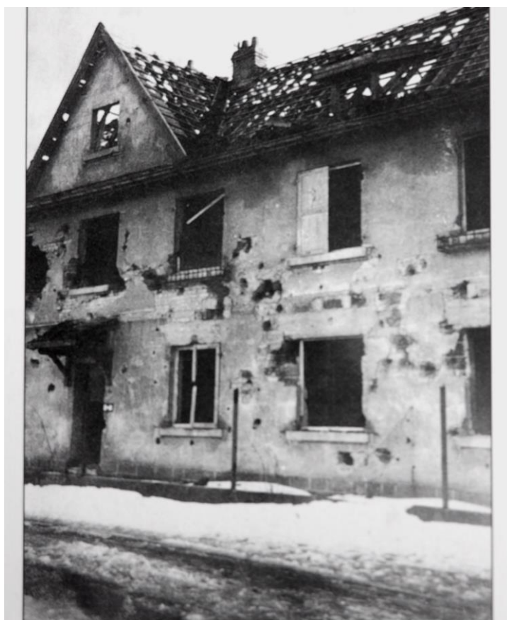
Maison endommagée rue de Neudorf.
