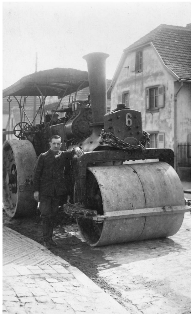
Réfection de la chaussée dans la rue du Général Leclerc.
