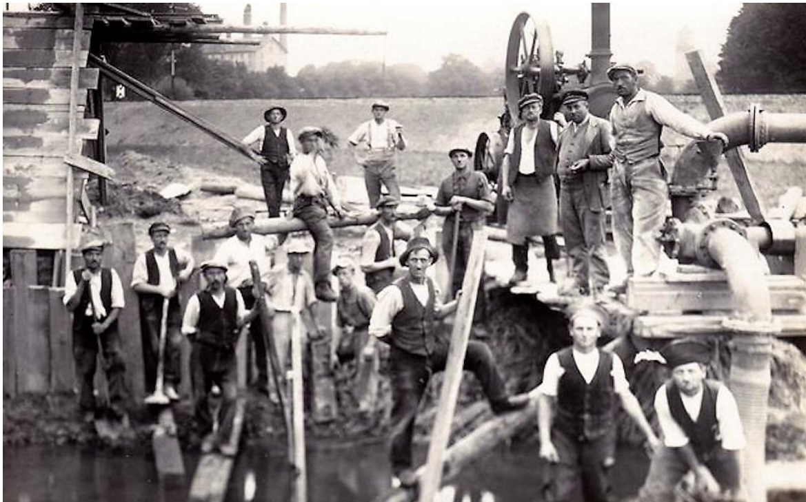
Ouvriers sur le chantier pour des travaux d'assainissement à Ostwald.
